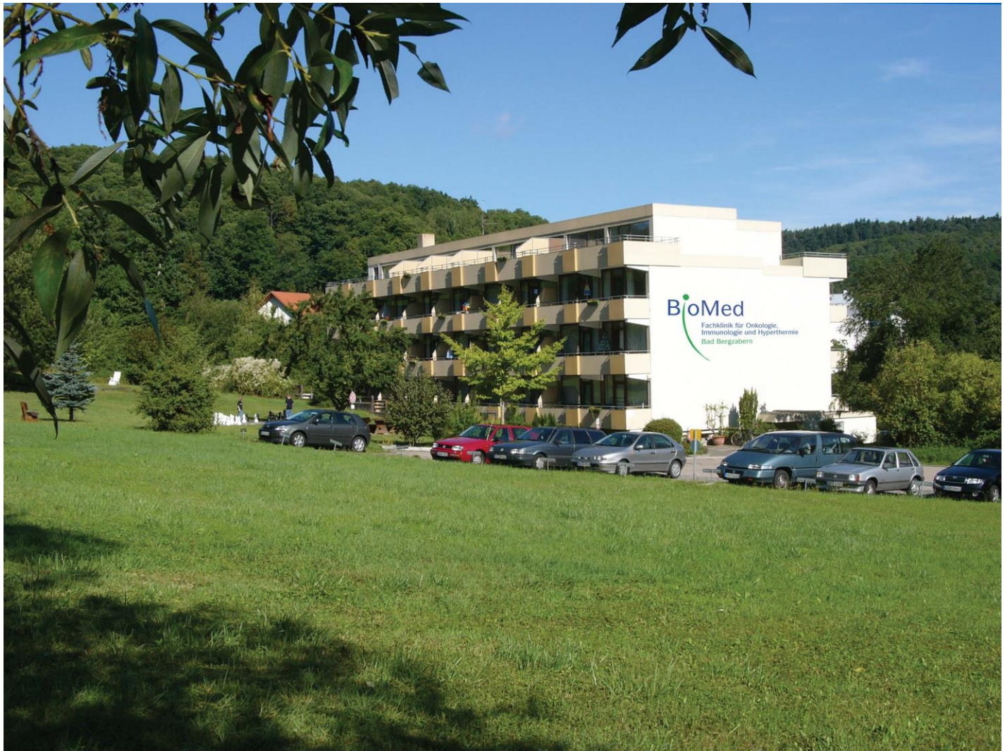
Blick auf Klinik-Gebäude Haus 8
